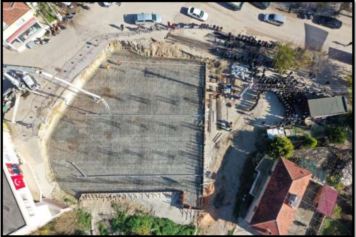
Çavdır Merkez Camii'nin Temeli Atıldı.
