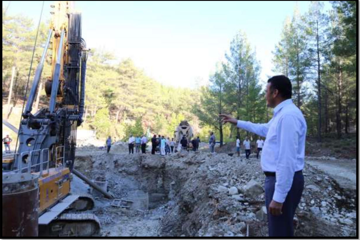
Lengüme (Çamlıova) Köprüsü'nün Temeli Atıldı.
